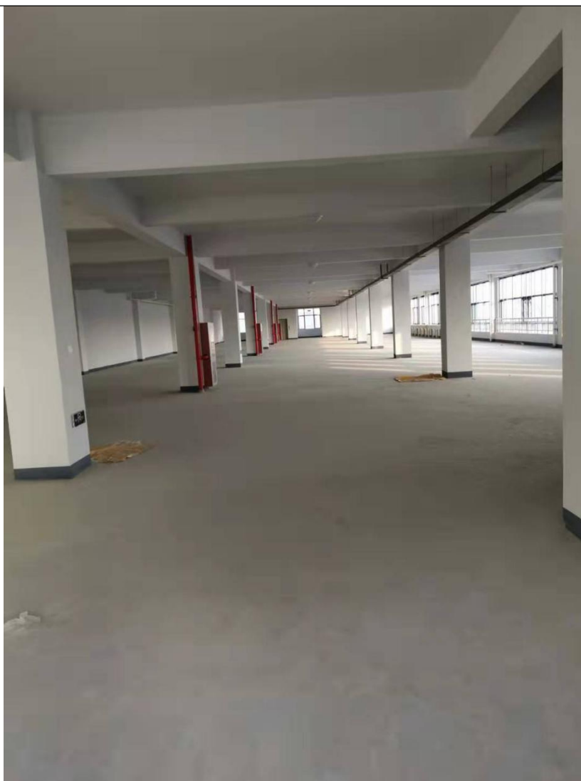
图 1-3 南通炎辰金属制品有限公司现有项目厂房（2F）
