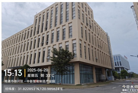
厂界西侧现状
